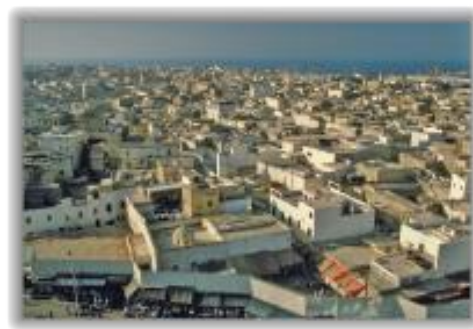
รูปถ่ายทางอากาศแสดงลักษณะของอาคาร บ้านเรือนในย่านตลาดเมืองเก่า ของประเทศโมร็อกโก
