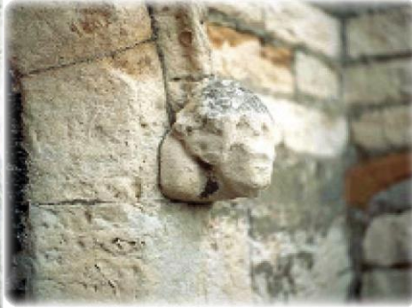
ก้อนปูน ความเสียหายที่เกิดจากฝนกรด ที่ปราสาทลึงคอล์น เขตการปกครองอังกฤษ ที่มา: th.wikipedia.org
